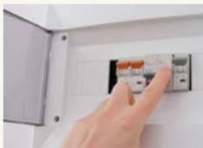
Los interruptores tienen dos posiciones, encendido y apagado, su función es la de actuar cuando se detecta una falla, es decir cortar el suministro eléctrico de la instalación y permitir su restablecimiento cuando se haya solucionado la anomalía.
