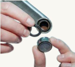
Es recomendable limpiar los aireadores periódicamente, al menos cada tres meses, desenroscándolos para eliminar los minerales acumulados. Estos depósitos pueden provocar goteo en las llaves al acelerar el desgaste de las empaquetaduras. Para restaurar su correcto funcionamiento, se sugiere
